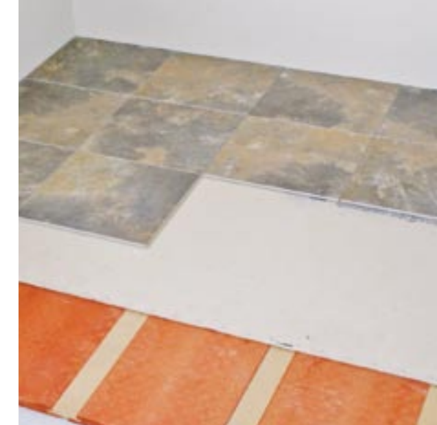
Pose d'un plancher de céramique sur revêtement Sono/Max avec panneau de fibro-ciment intermédiaire.
