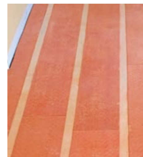
Système Sono/Max 17 installé sur plancher en béton
